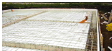
Плитный фундамент сохранит надежность и в условиях сезонного смещения грунта
